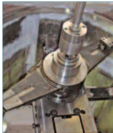
Mobile Bearbeitung der Zylinderaufnahme im Pressenkopf.
